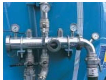
µ-Filter verhindern das Eindringen verunreinigter Luft in die Kessel.
